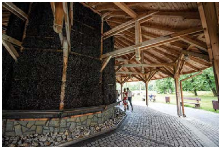
Jaworzańska tężnia zasilana jest solanką, która jest naturalnym środkiem kosmetycznym i leczniczym o wysokiej zawartości jodu. fot. Urząd Gminy Jaworze
