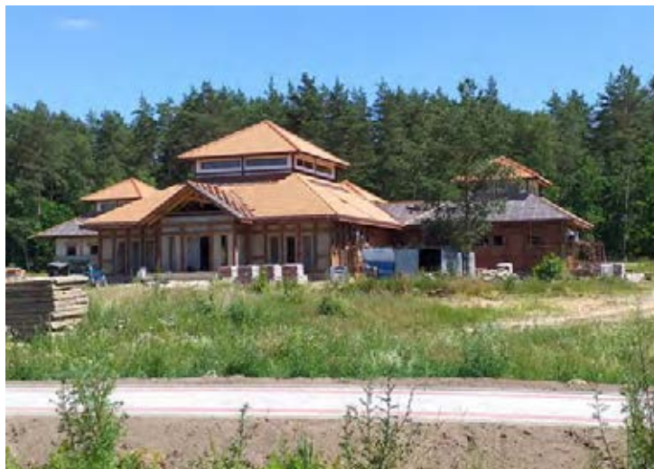
Pawilon uzdrowiskowy w trakcie budowy fot. Archiwum Gminy Górowo Iławeckie
